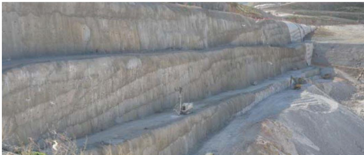
Εικόνα 5.1.1.1: Εφαρμογή κατακορύφων στεγανών πρανών σε ΧΥΤΑ
